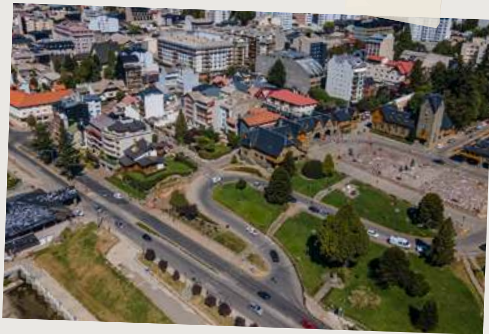
↻ Hormigón acceso a las Victorias
