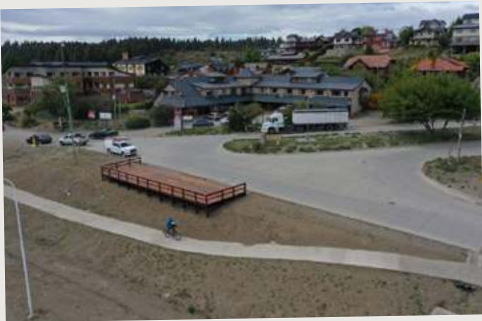
↻ Pavimiento Barrio Las Victorias
