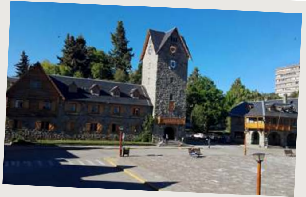
↻ Soterramiento eléctrico Centro Cívico
