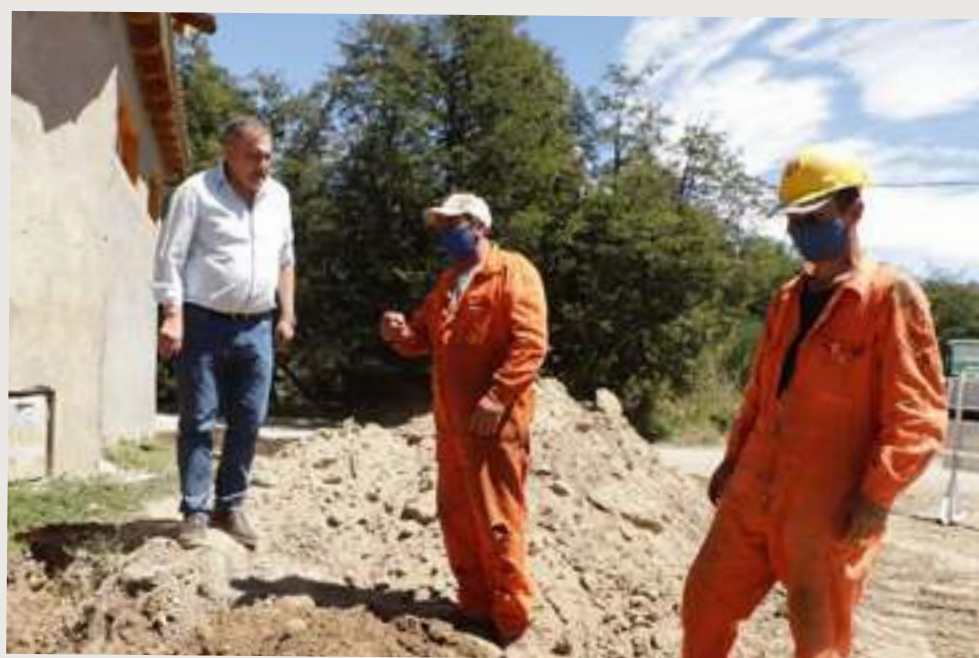
↖ Red de gas Barrio Nueva Jamaica
